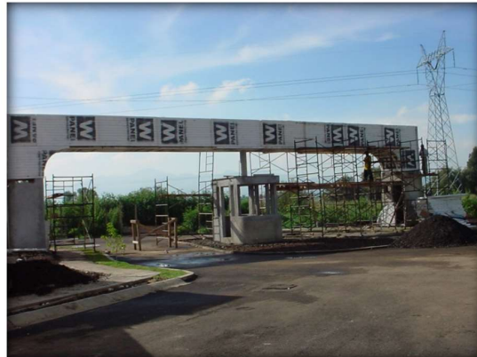
Imagen 36 Vista construcción pórtico acceso. Fraccionamiento Arko, San José. Fuente: propia
