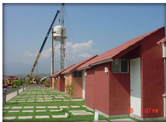
Imagen 59 y 60: Colocación de tanque elevado sobre su estructura de base. Fraccionamiento Arko San Antonio. Fuente: propia
