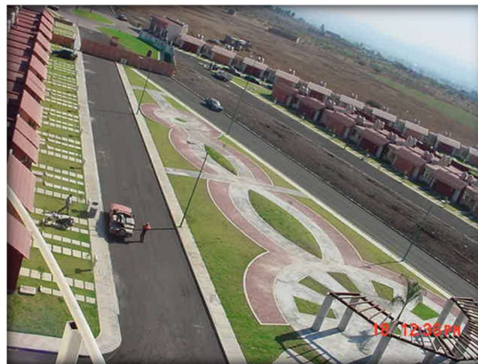
Imagen 21: Calle de acceso 3kms de longitud. Fraccionamiento Arko San Antonio. Fuente: propia
