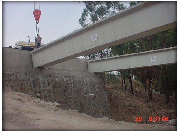
Imagen 69 y 70: Avance de proceso constructivo en la colocación de vigas "T" para el puente. Fuente: propia
