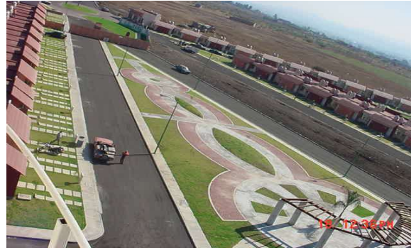
Imagen 48 Plaza de acceso. Fraccionamiento Arko San Antonio. (Fuente: González, 2004)
