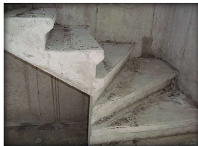
Imagen 11,12 y 13: Diseño de Cimbras para escaleras y su terminación, Fraccionamiento Ario 1815. Fuente: propia
