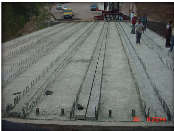
Imagen 71 y 72: Terminación de colocación de vigas "T"; Construcción de glorieta y pórtico de acceso. Fraccionamiento Misión San Diego. Fuente: propia
