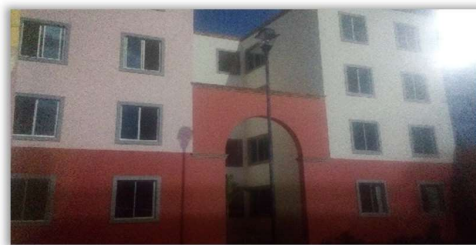
Imagen 1 Vista frontal de departamentos. Fuente: propia
