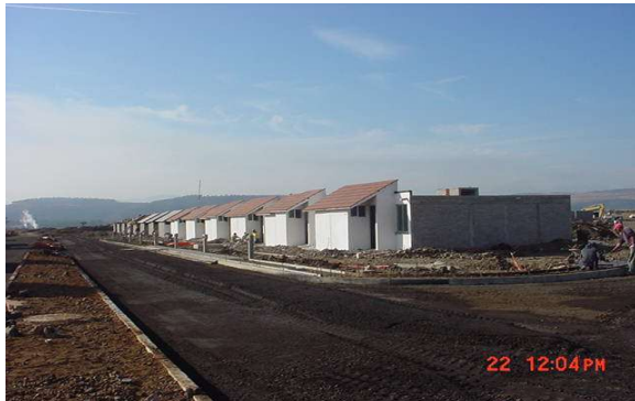
Imagen 51: Preparación de terreno de calle principal. Fraccionamiento Arko San Antonio. Fuente: propia
