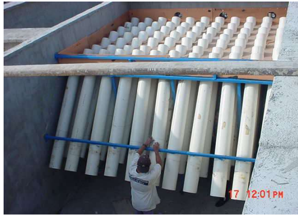
Imagen 63 y 64: Construcción de planta de tratamiento de aguas negras. Fraccionamiento Arko San Antonio. Fuente: propia
