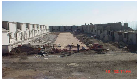
Imagen 54: Colocación de adocreto diferente Fraccionamiento Arko San Antonio. Fuente: propia
