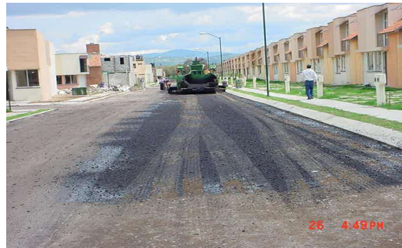
Imagen 52: Tendido de carpeta asfáltica. Fraccionamiento Arko San Antonio. Fuente: propia
