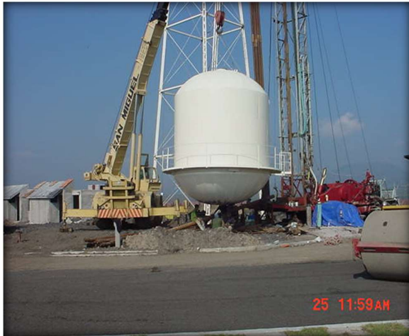
Imagen 57 y 58: Fabricación de estructura para dos tanques elevados con capacidad de 90 m 3 . Fraccionamiento Arko San Antonio. Fuente: propia
