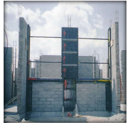
Imagen 8,9 y 10: Diseño de Cimbras de cimentación y castillos, Fraccionamiento Ario 1815. Fuente: propia
