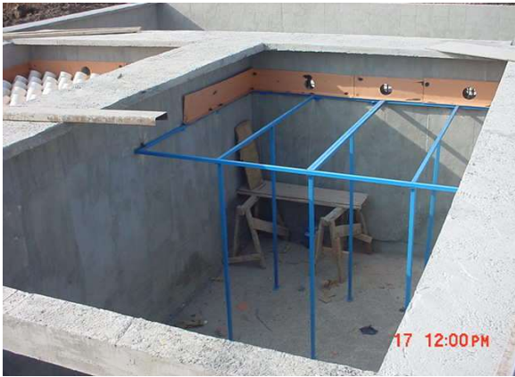
Imagen 63 y 64: Construcción de planta de tratamiento de aguas negras. Fraccionamiento Arko San Antonio. Fuente: propia
