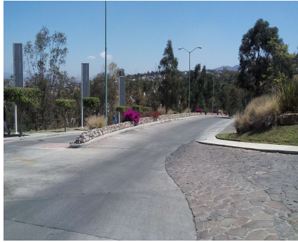
Imagen 22, 23 y 24: calle de acceso en concreto estampado. Fraccionamiento Misión San Diego. Fuente: propia
