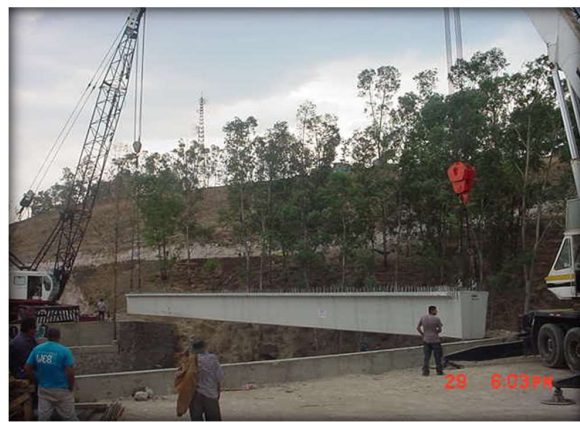
Imagen 67 y 68: Descarga y Colocación de vigas "T" en puente de acceso del Fraccionamiento Misión San Diego. Fuente: propia
