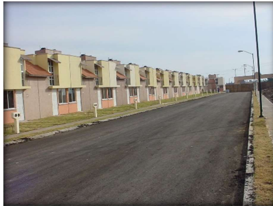
Imagen 16: Viviendas de Fraccionamiento Casas Arko San Jos . Fuente: propia
