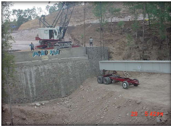
Imagen 67 y 68: Descarga y Colocación de vigas "T" en puente de acceso del Fraccionamiento Misión San Diego. Fuente: propia
