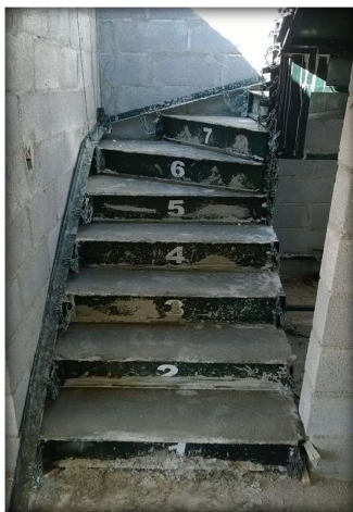
Imagen 11,12 y 13: Diseño de Cimbras para escaleras y su terminación, Fraccionamiento Ario 1815. Fuente: propia
