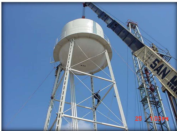
Imagen 59 y 60: Colocación de tanque elevado sobre su estructura de base. Fraccionamiento Arko San Antonio. Fuente: propia
