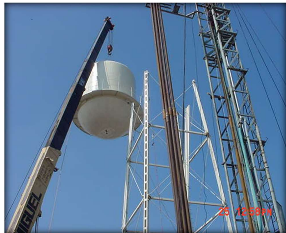
Imagen 57 y 58: Fabricación de estructura para dos tanques elevados con capacidad de 90 m 3 . Fraccionamiento Arko San Antonio. Fuente: propia
