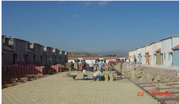
Imagen 53: Colocación de adocreto en vías secundarias. color Fraccionamiento Arko San Antonio. Fuente: propia
